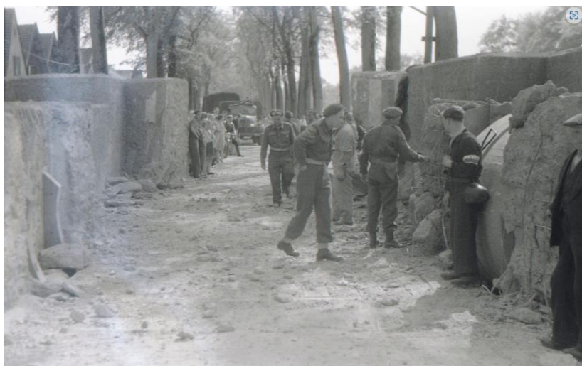
Engelse militairen bij de immens grote blokken beton die de Duitsers gebruikten ter afsluiting van de toegangswegen
