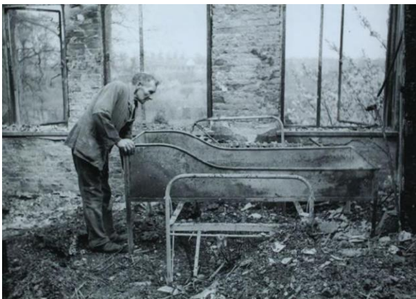
Dat wat er overbleef na de brand in het Algemeen Ziekenhuis
