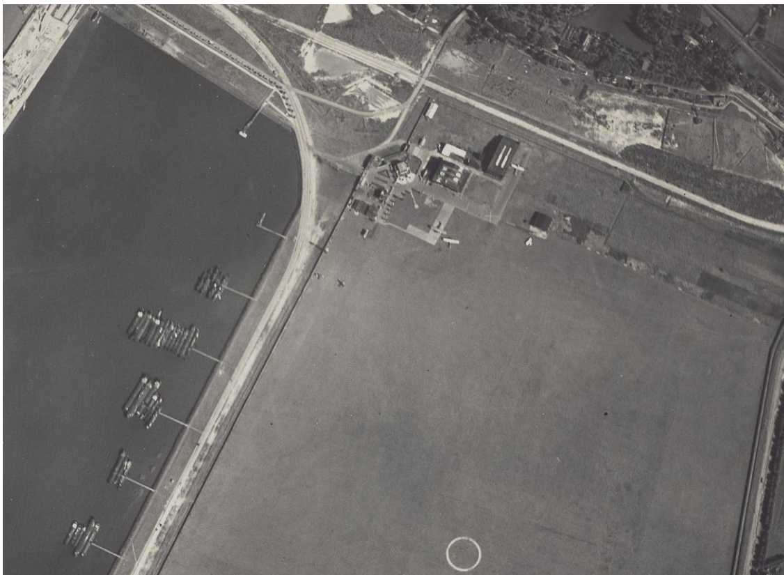
Het vliegveld Waalhaven in Rotterdam met in het midden de grote KLM-hangar.
