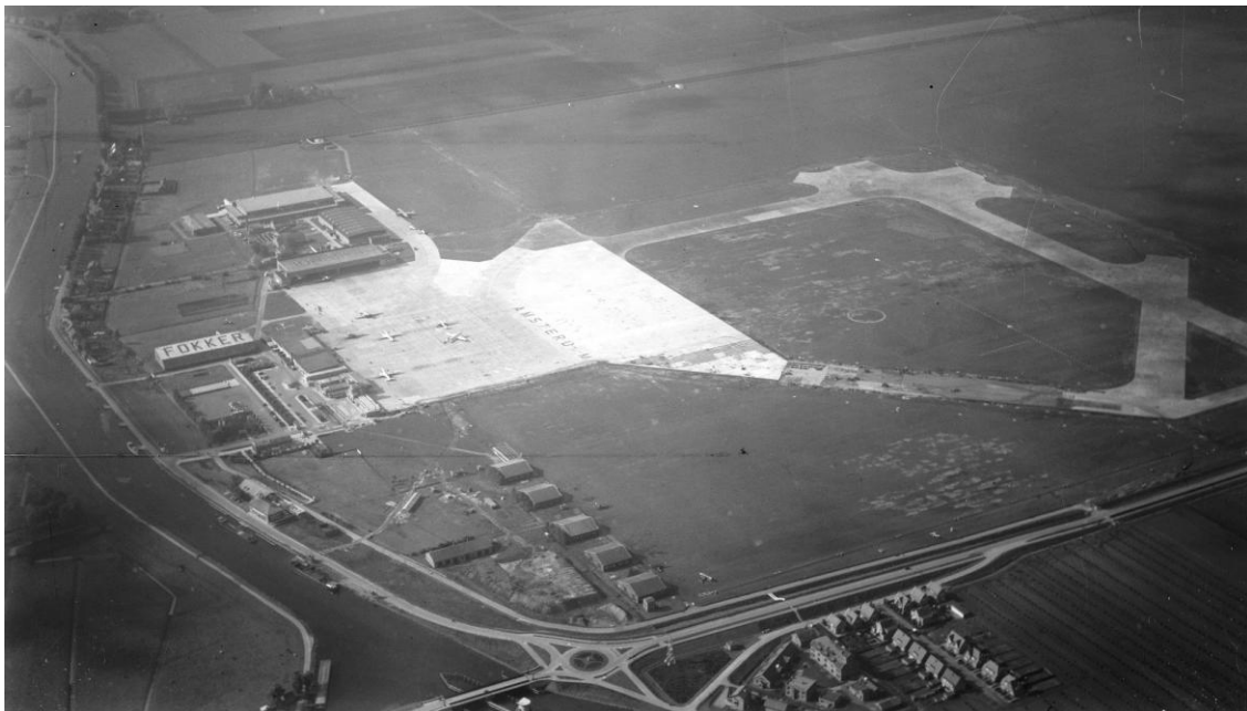
Schiphol in 1937: de aanleg van het betonnen banenstelsel is in volle gang en links bovenaan zijn ook hangar D en de motorenwerkplaats van de KLM Technische Dienst verzezen.
