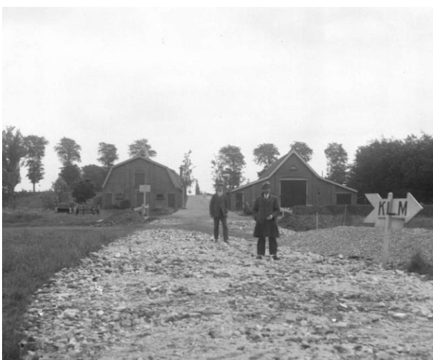
De toegang tot het vliegveld in 1926: een uit puin verhard pad vanaf de Ringvaartdijk.
