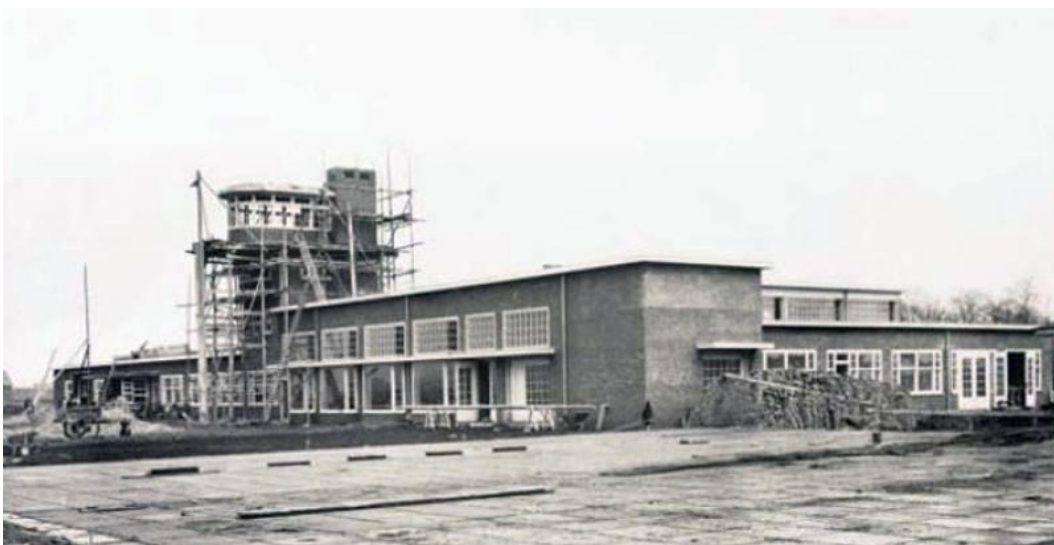
1928: stationsgebouw in aanbouw.
