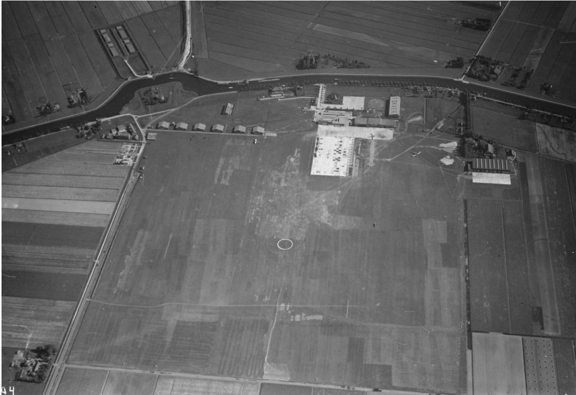
Schiphol in 1929: Aan de uitbreiding van het platform voor het nieuwe stationsgebouw wordt hard gewerkt, de Bessonnew-tenthangar links van hangar C is verwijderd om plaats te maken voor de nieuwe hangar B en de bouw van woningen voor het KLM-personeel naast de kazerne is begonnen. Bij het fort aan de overzijde van de Ringvaart is het Munitiemagazijn Amstelveen zichtbaar.
