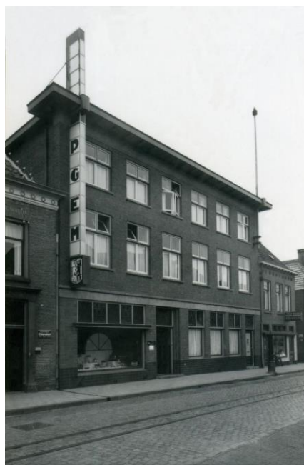
Het PGEM-kantoor op de bovenste etage
