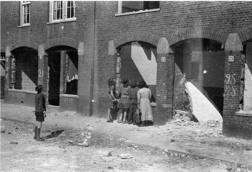
Door 'houtrovers' gesloopte woningen in de Laing's Nekstraat nummers 21-25. De huizen waren gebouwd door het Bouwfonds Handwerkers Vriendenkring. Stadsarchief Amsterdam-collectie Hofman
