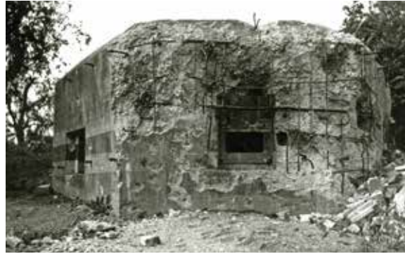
Deze zwaar beschadigde S-kazemat (een 'stekelvarken') laat zien hoe effectief het Duitse geschut was. Deze kazemat lag iets onder de rivierkazemat-zuid, augustus 1940. (foto: J.J. Overwater, collectie Stichting Menno van Coehoorn)
